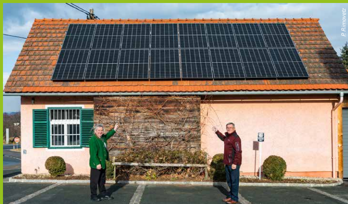
Bgm. Josef Niggas (links) und Obmann der Tiefkühlgemeinschaft Blumegg Franz Niggas (rechts) bei der neuen Photovoltaikanlage beim Tiefkühlhaus in Blumegg.
