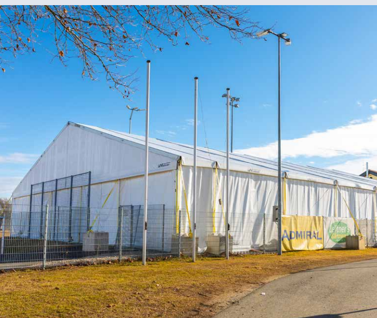
Die Eisanlage mit Überdachung.
